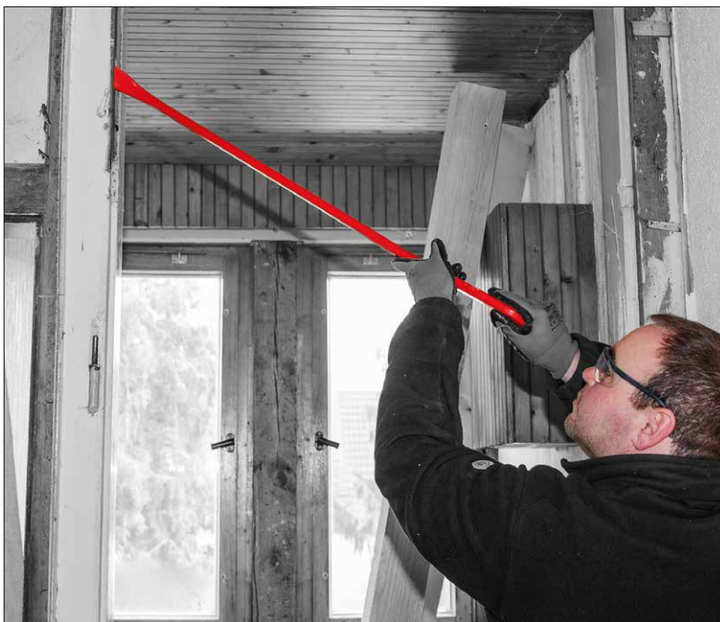
gutes Handling auch bei Abbruch aus größerer Distanz durch langen Hebelarm
